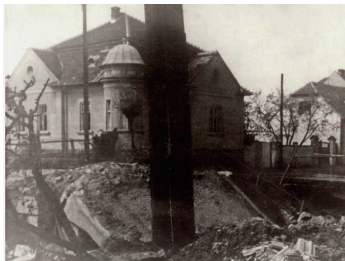
Most přes Syrovínku v Nádražní ulici zničený ustupující německou armádou dne 18. dubna 1945. (foto Vratislavský)
