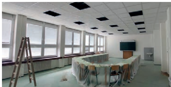
Rekonstrukce stropu v jazykové učebně
