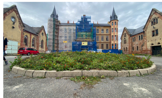
1 Čelní pohled na zámek z nádvoří
