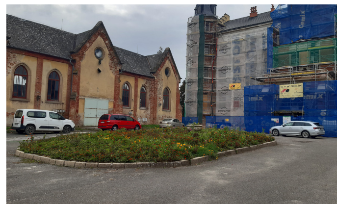
Asfaltový povrch na nádvoří
