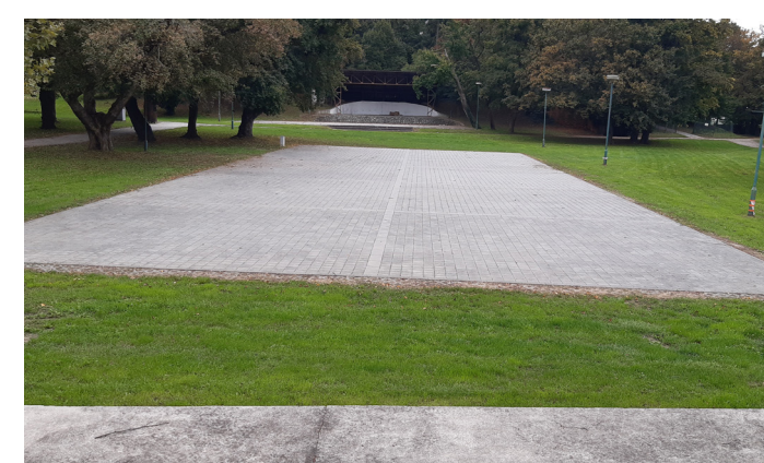
Zpevněné plochy pro shromažďování - betonová dlažba
