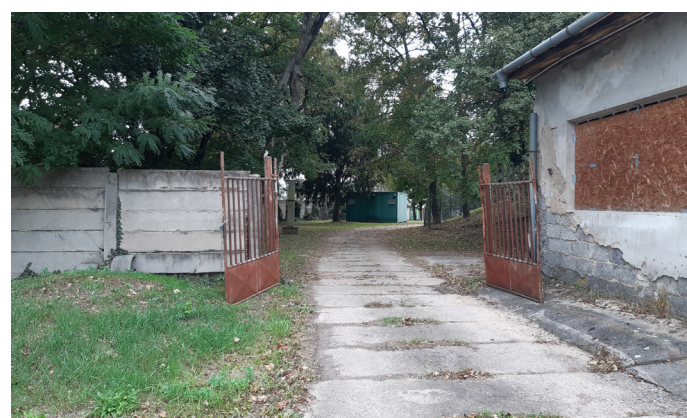
Betonové panely podél skleníku
