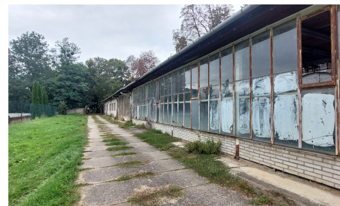
Stávající skleníku se skladovými prostory
