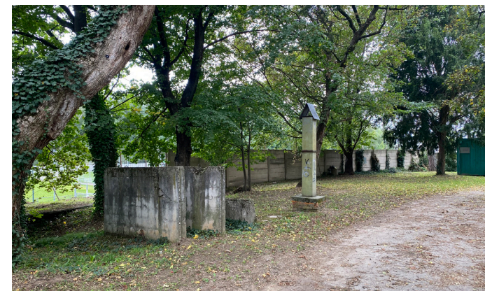
3 Zbytky stavebních objektů
