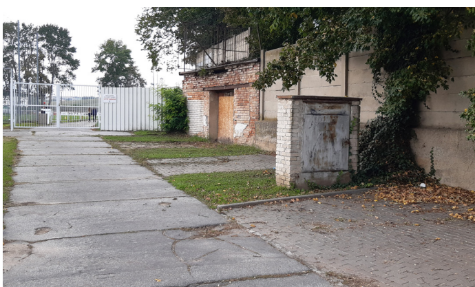
Vstup k fotbalovému hřišti
