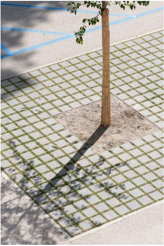
parkování - zatravňovací dlažba
