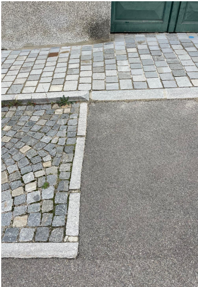
hlavní poježděná komunikace + parkování - asfalt/žulová kostka
